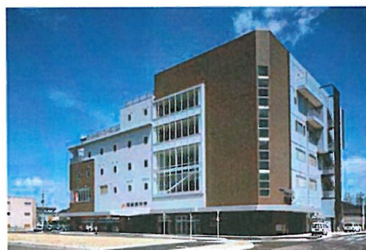
鹿児島本線・福工大前駅ビル内
